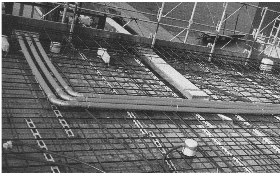
Abbildung 2: Diverse Leitungsführungen in einer Stahlbetondecke
